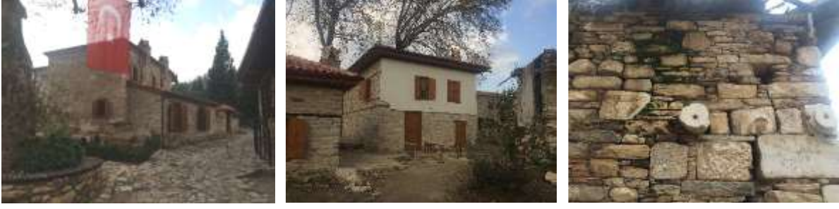
Şekil 16. 260 Ada 3 parselde 2022-2023 yıllarında rekonstrüksiyonu yapılan ev, 256 Ada 17-16 parselde restore edilmiş konutlar ve Zıbrın Sokak, 241 ada 2 parselde devşirme malzeme kullanılan dış duvar ile 1957 yılı depremi izi (Kökçü, 2023)
