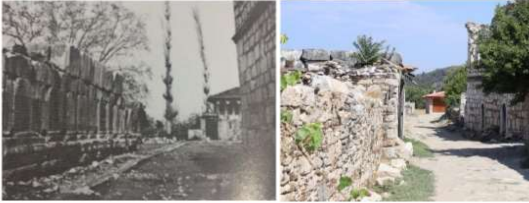
Şekil 13. Soldaki; Meclis Binası, Osmanlı Çeşmesi Osman Hamdi Bey Arşivi, 1906 (Söğüt, 2019, s: 148) vesağdaki; Mehmet Eskişar Evi, 2021.
