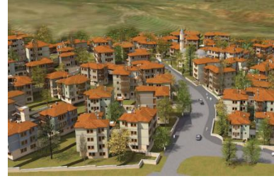
Şekil 5. Gaziantep Şehit Kamil Konutları (TOKİ, 2016)
